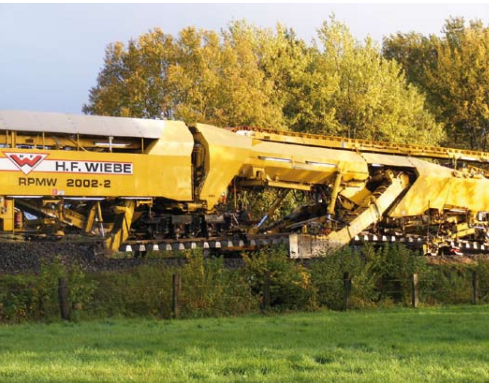
Zur Sanierung des Abschnitts zwischen Mulmshorn und Elsdorf setzte auch die Firma Wiebe mit der RPMW 2002-2 schweres Baugerät ein Foto: UH
